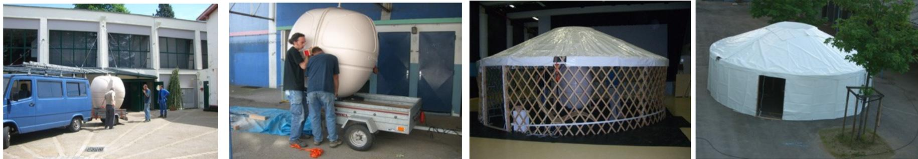
**structure auto porteuse circulaire de 6,50 m de diamètre. Ne nécessite aucun points d'ancrage ni haubans.**
